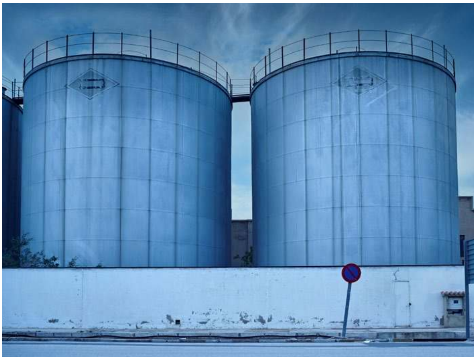
Figura 5. Tanque con corrosión
