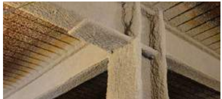
Imagen 2. Estructuras de edificaciones con protección ignífuga. Fuente: The Balancesmb
