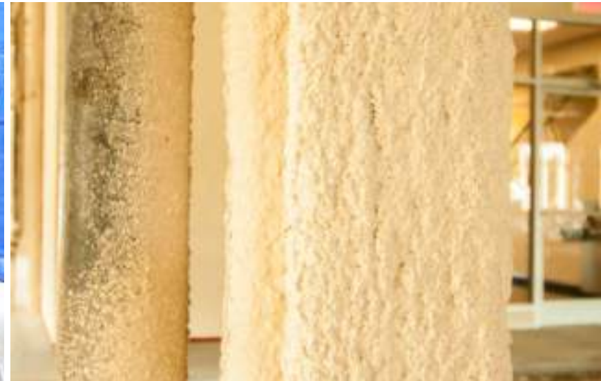
Imagen 6. Mastic y recubrimientos intumescentes utilizados para protección de pequeñas estructuras y sistemas instrumentados. Fuente: UL.com
