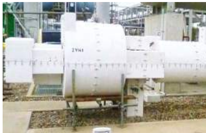
Imagen 3. Ejemplo de revestimiento para proteger válvulas y actuadores ante "jet fire". Fuente: Fireprotection
