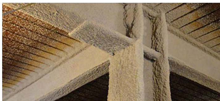
Imagen 2. Estructuras de edificaciones con protección ignífuga. Fuente: The Balancesmb
