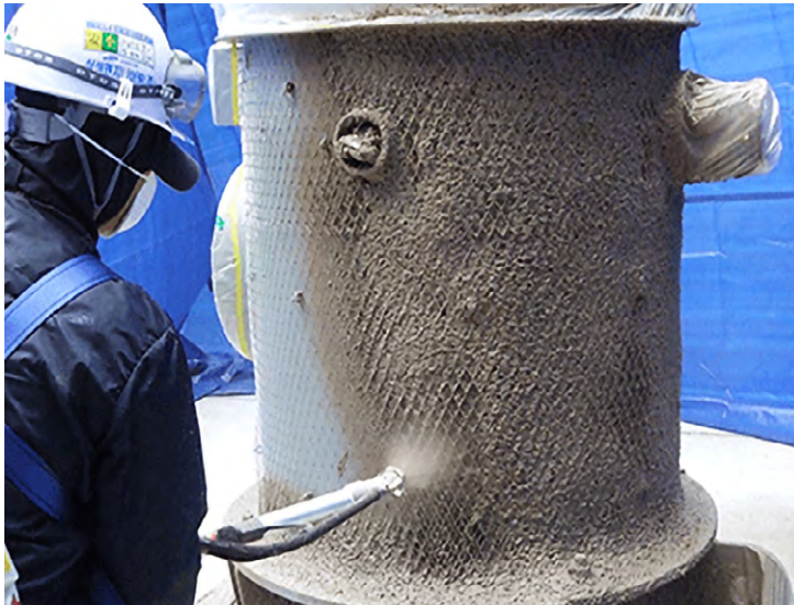
Imagen 5. Aplicación de protección ignífuga alrededor de equipos de proceso. Fuente: GCPAT
