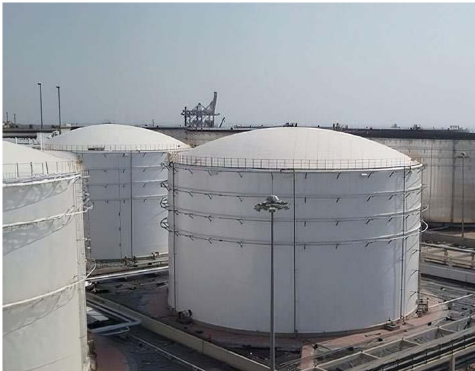
Figura 2. Tanque de techo fijo
