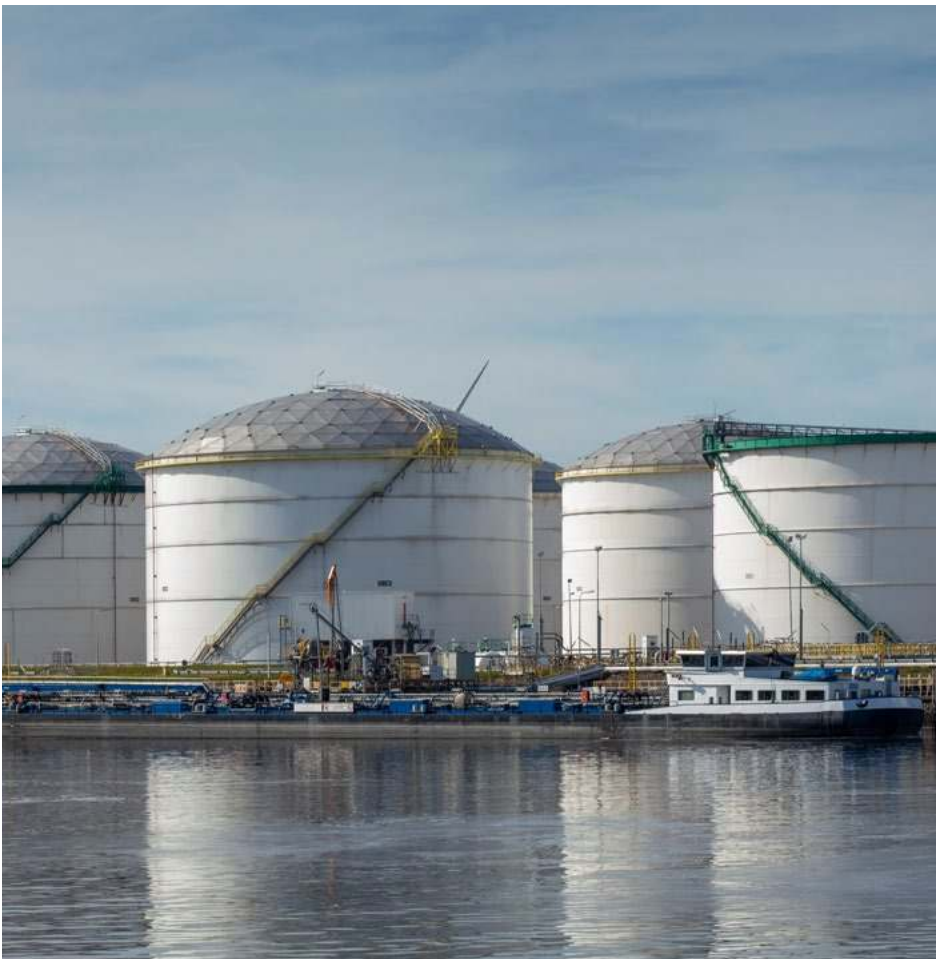
Figura 4. Tanque de techo flotante interno
